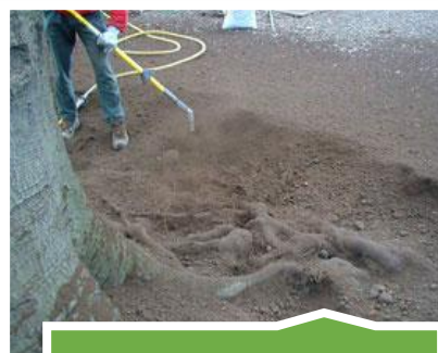
Dégagement autour des racines
